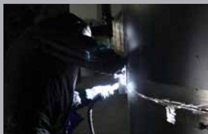
Kann ein Behälter aufgrund der baulichen Gegebenheiten nicht in einem Stück in die entsprechenden Räumlichkeiten eingebracht werden, führen spezialisierte und erfahrene Teams der **ISPAG** eine Platzschweissung durch.
